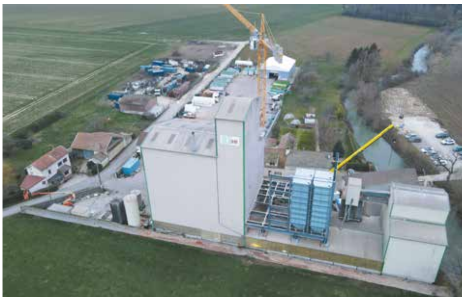
L'extension a été dimensionnée pour accueillir de futurs équipements.
