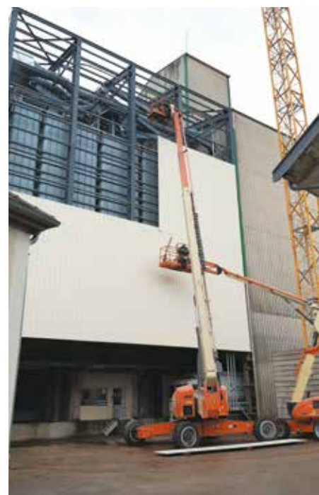
Le nouveau bâtiment reçoit 29 silos, dont 9 pour les matières premières et 20 pour les produits finis.
