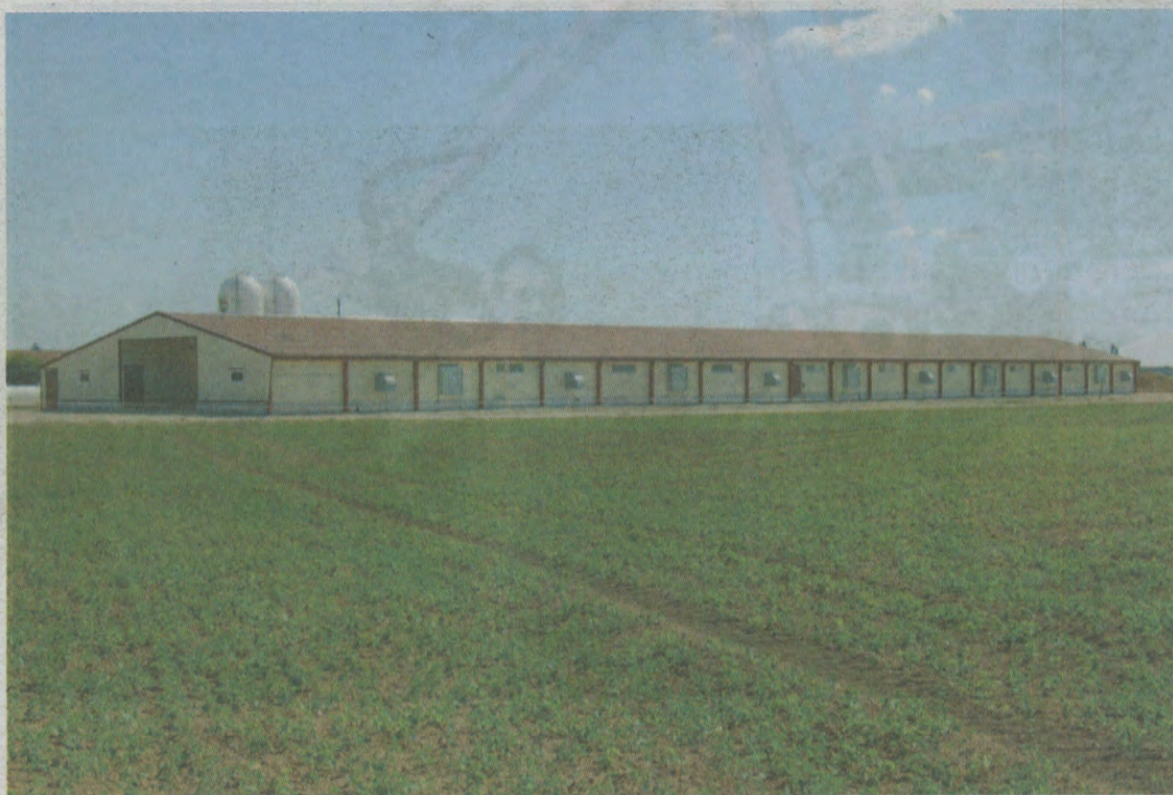
Un nouveau bâtiment à Esbarres, situé à la sortie du village direction Aubigny-en-Plaine.
